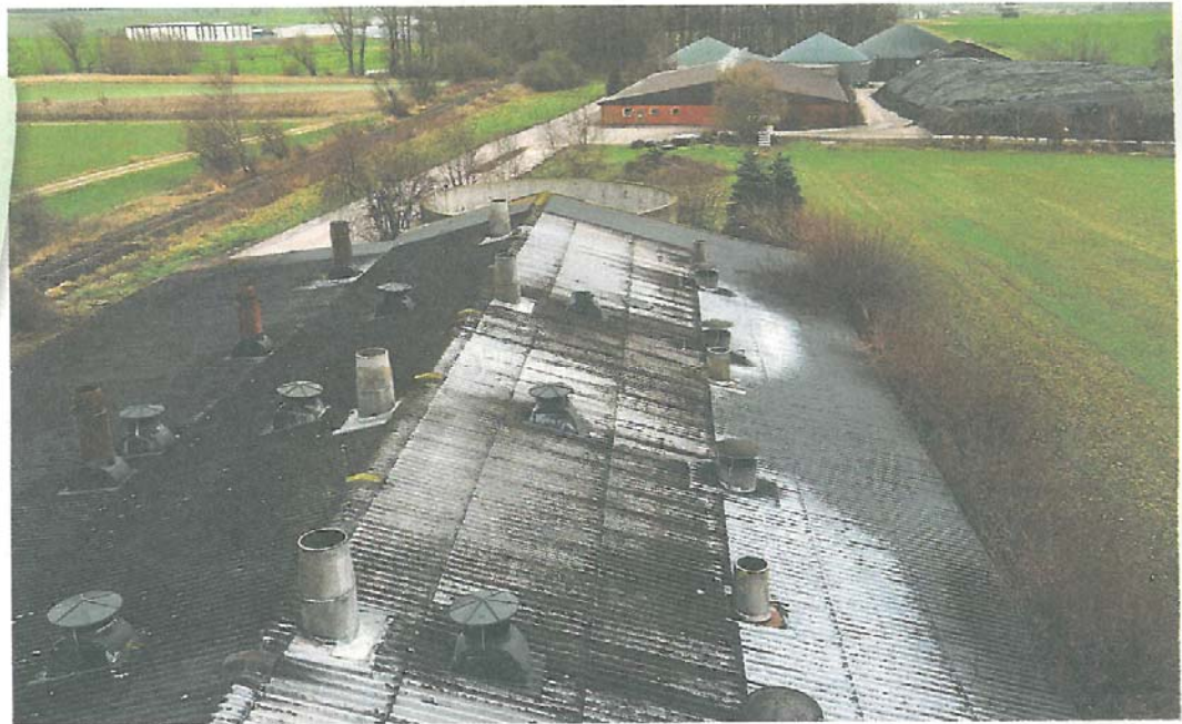
Beide Ställe des Schweinemastbetriebes Hake in Borgentreich, Kreis Höxter, sind mit schlaunen Zählern, sogenannten Smartmetern, ausgestattet. Mit dieser Technik wollen die Betriebsleiter Franz-Josef und Alexander Hake den Energieverbrauch der jeweiligen Fütterungs- und Lüftungsanlagen untersuchen.
